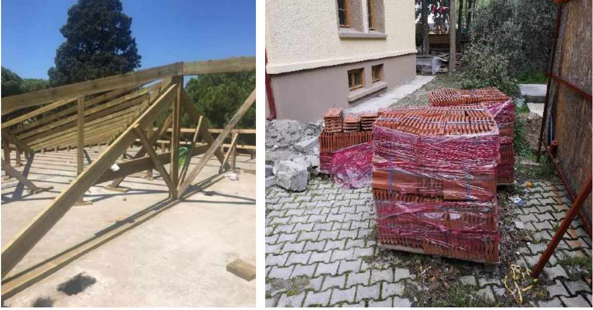
Şekil 16: Ahşap Oturma Çatı ve Marsilya Kiremit
