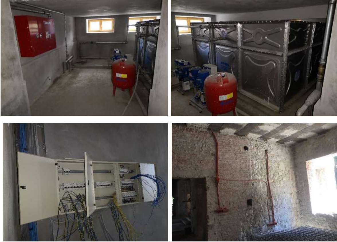
Şekil 12: Eski Hükümet Konağı Mekanik Tesisatlarında İyileştirme Çalışmaları
