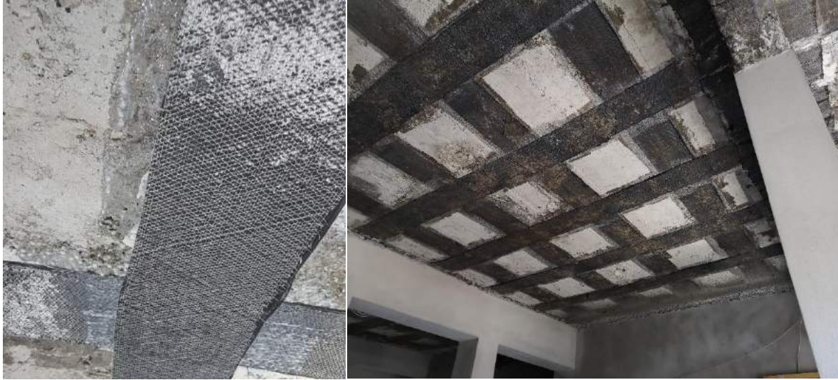
Şekil 15: FRP Kumaş ile Güçlendirme Çalışması
